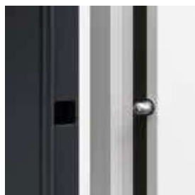
bezpečnostné trne proti vysadeniu – KWARC III
